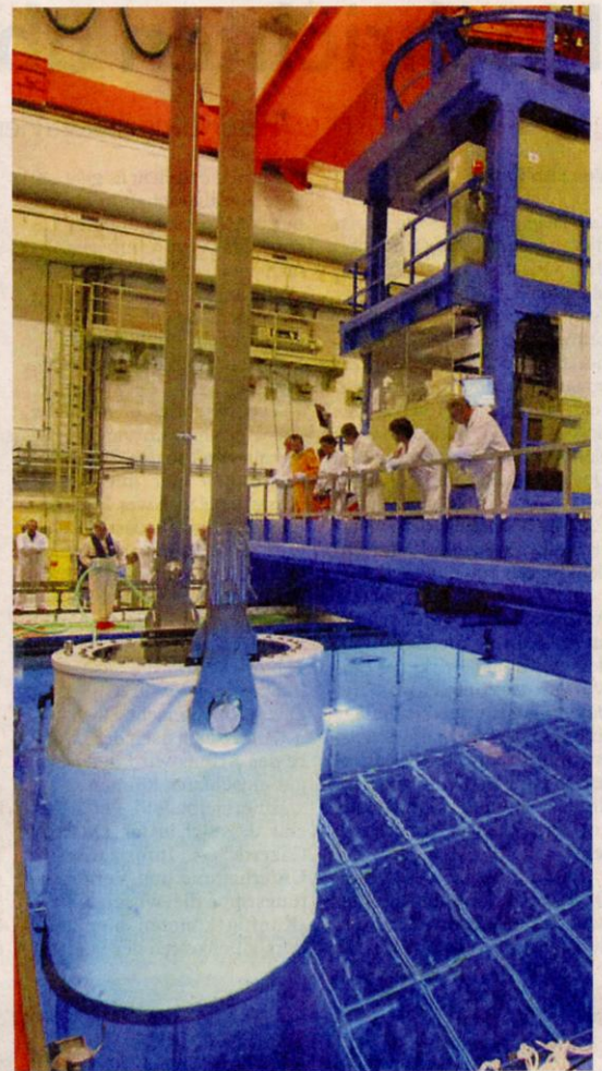
Brennelemente im Abklingbecken im Kernkraftwerk Krümmel. Für die Endlagerung sollen sie unter die Erde. Archivfoto: Jann
